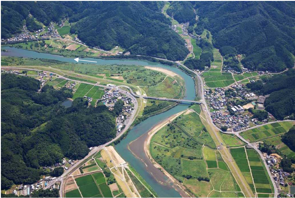
写真 2-11 蛇行した由良川下流淡水区間 (21.0k付近) (令和3年7月撮影)
