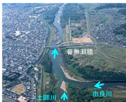
写真 8-2 中流部 堀地区付近
