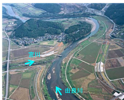
写真 8-3 下流部（湛水区間） はび 波美地区付近
