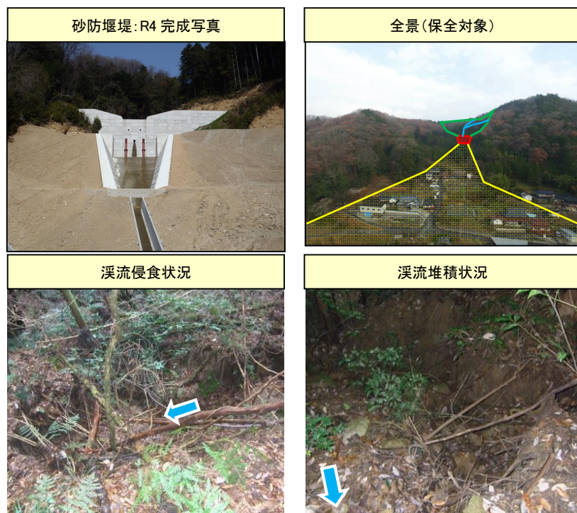
図 2-3 岡山県による土砂流出対策施設の整備事例
