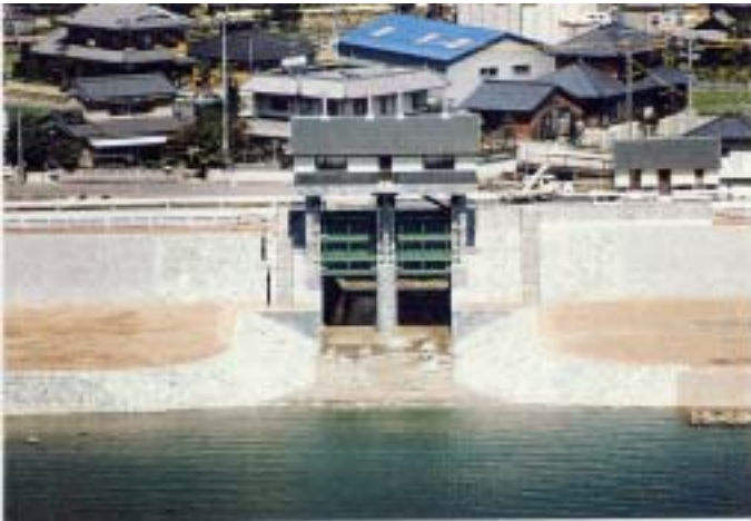
写真 9-1 田淵樋門(肱川 5.4k 右岸) 大洲工事事務所撮影
