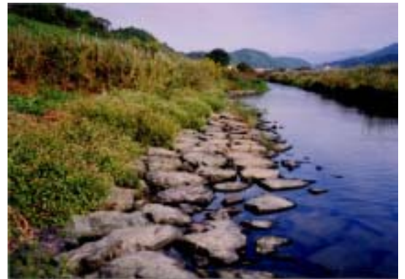
写真 8-1(3) 矢落川多自然護岸施工箇所 (1.4～1.6k 右岸) 大洲工事事務所撮影
