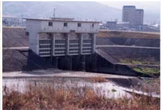
写真 9-2 都谷川排水樋門(矢落川 0.8k 左岸) 大洲工事事務所撮影
