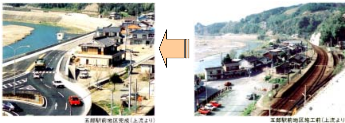
写真 4-2(2) 五郎駅前地区改修事業
