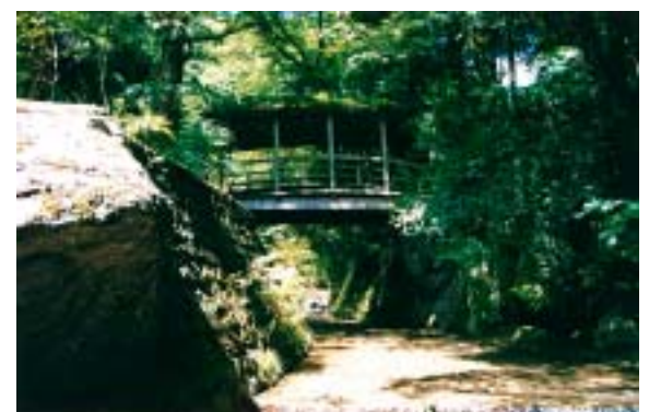
6. 御幸の橋（屋根付き橋）
