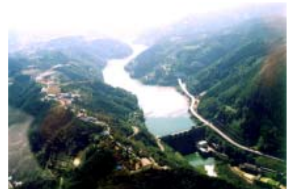
写真 8-1(4) 鹿野川ダム湖 大洲工事事務所撮影
