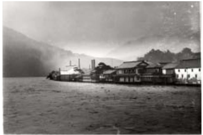
昭和 18 年 7 月洪水 肱川橋上流
