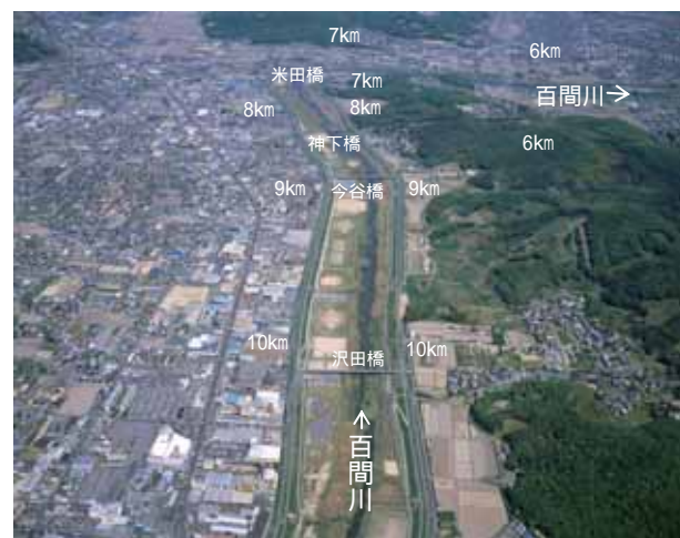
百間川9k ~ 10k付近(河川敷整備状況)
