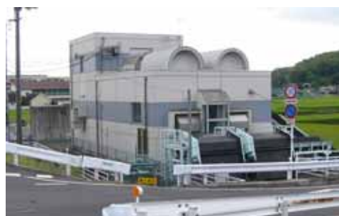
倉安川排水機場
