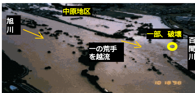
岡山県土木部河川課HP
