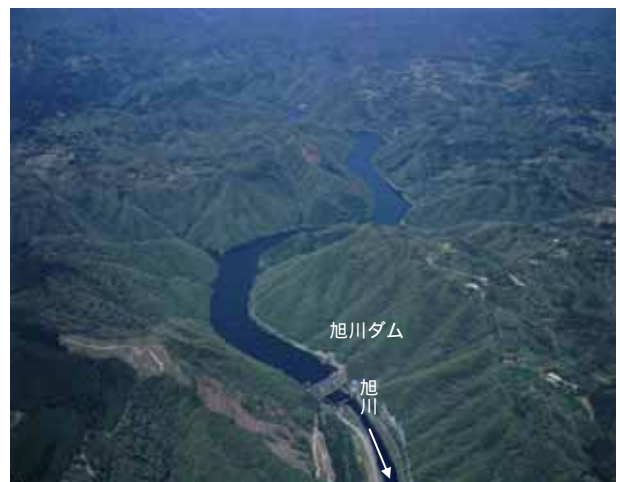
旭川ダム及び貯水池を望む
