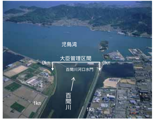
百間川河口より1k付近(百間川河口水門)
