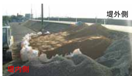
緊急復旧完成状況
