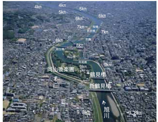
旭川9k ~ 10k付近(岡山後楽園付近)
