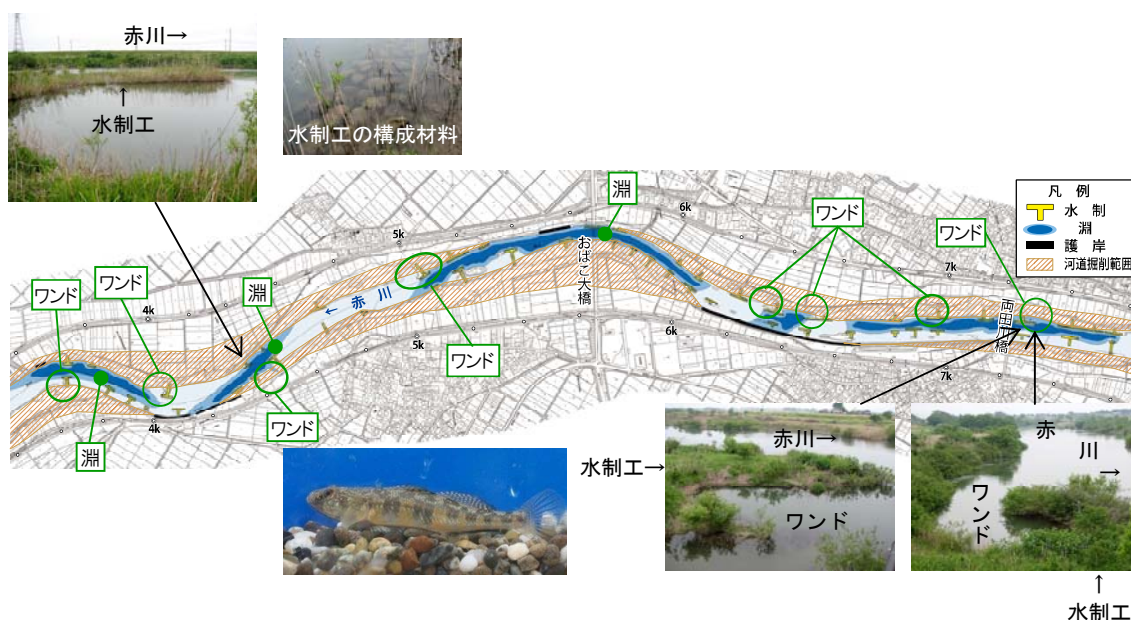
4k～8k 付近の水制工の配置状況
