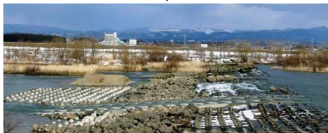
魚道設置後（平成 19 年 3 月）
