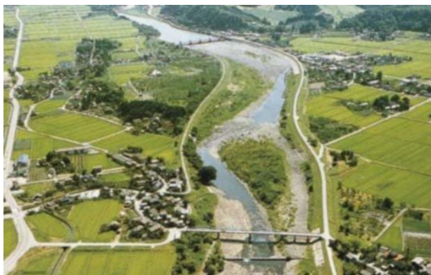
平成元年 7 月 赤川頭首工下流
