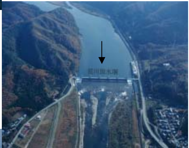
下流部 荒川頭首工 (平地部)
