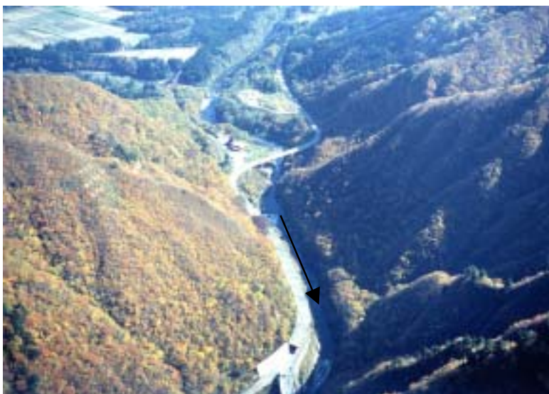
中流部 赤芝ダム周辺 (山間狭窄部)
