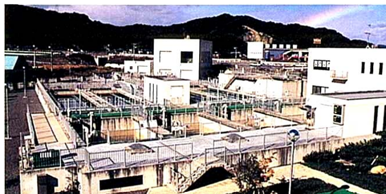
高屋川河川浄化施設
