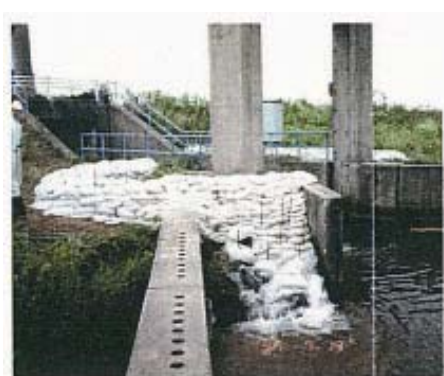
樋門部からの漏水事例
