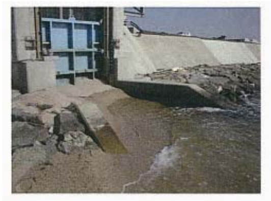
樋門吐口の土砂堆積状況
