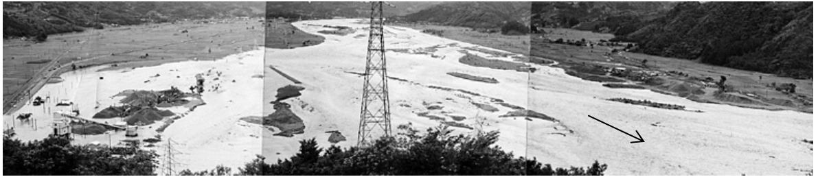
姫川右岸（大野地区）の堤防が決壊（糸魚川市史昭和編より）
