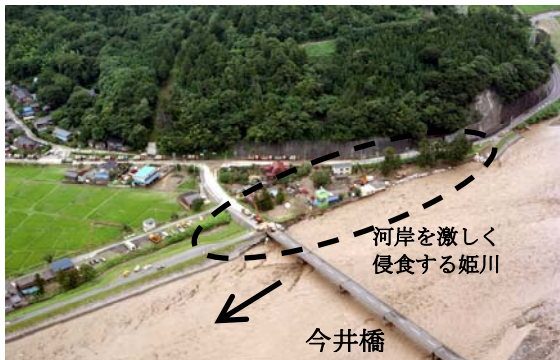
河岸洗掘による破堤状況（糸魚川市上刈地先）
