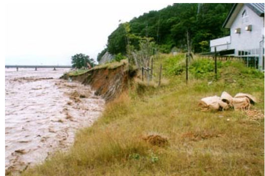
堤防欠壊状況（糸魚川市大野地先）
