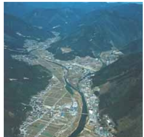
引原川合流点付近 (45k0 付近)
