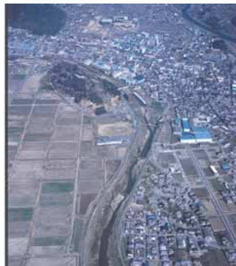
栗栖川（鍵田井堰～芝田橋）
