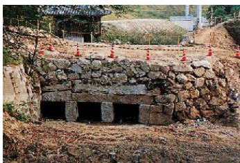
▲石井樋取水施設
