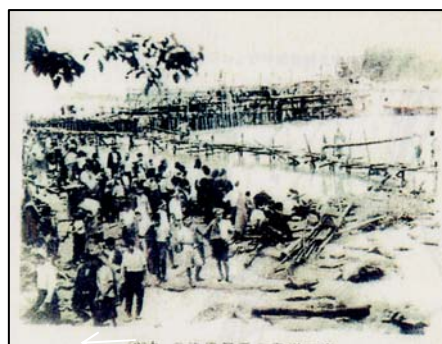
▲決壊箇所の復旧工事
