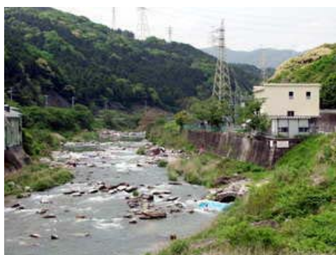
写真5-1-3 川上第五発電所
