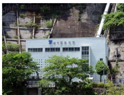
写真5-1-4 鮎の瀬発電所
