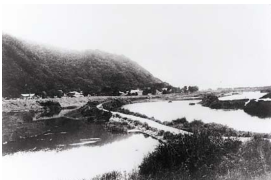
改修工事前の亀の甲付近
