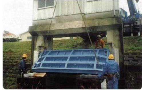
水門・樋門の点検
