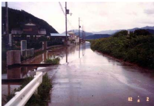
小浜市水取地区(右岸 0.6k 付近)の浸水状況
