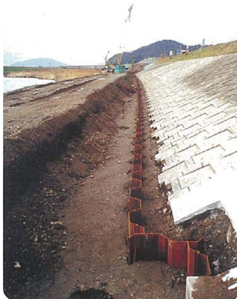
漏水対策工事実施状況
