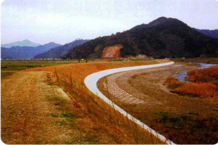
遠敷川左岸築堤・護岸工事後
