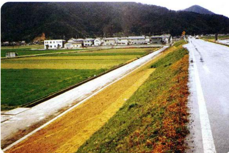
国富地区築堤工事後
