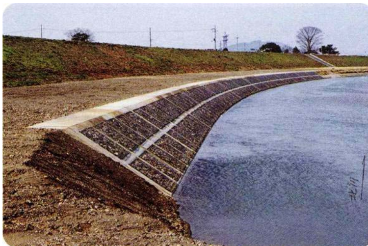
府中地区護岸工事後
