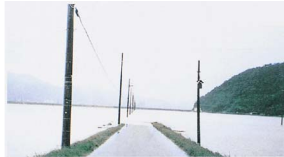
北川4.0km付近右岸の霞堤からの逆流による浸水状況(小浜市)
