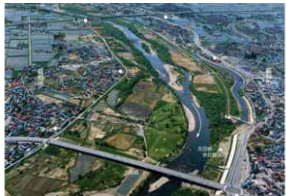
北上川合流点より 3.0km 地点の雫石川 高水敷には広大な河畔林がある他、グラウンド等が整備されている
