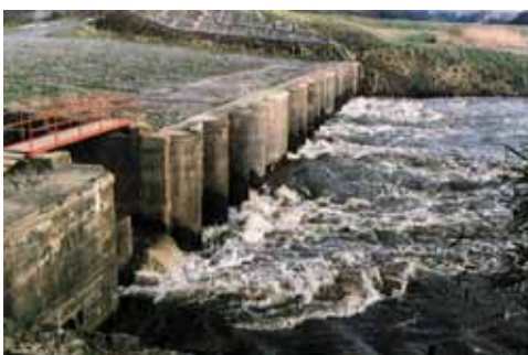
写真上：脇谷洗堰 写真下：鞆波洗堰
