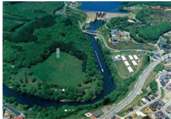
四十四田ダムの下流は川幅が狭く斜面が河川間際まで迫っている
