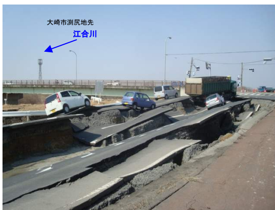
江合川左岸 27.6k 付近 (大崎市古川刈尻地先) ※地震により縦断クラック発生
