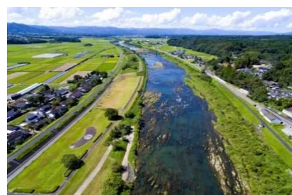
向町河川公園【あさぎり町】
