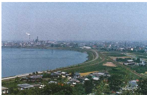
【 はきはら 萩原堤防】 - 八代市 -
