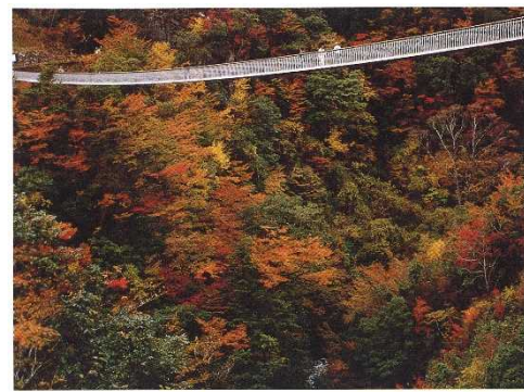
【梅の木轟公園吊橋】
