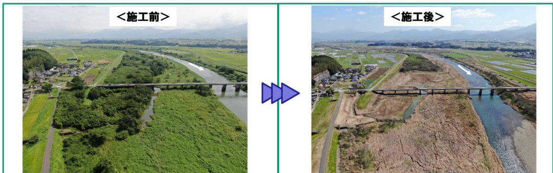
図 9-2 河道内樹木伐採の状況
