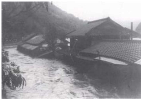
中流部の浸水状況（球磨村神瀬地区）
