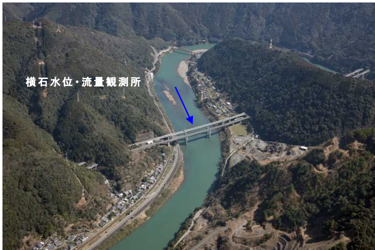
【球磨川 13k 付近の横石水位・流量観測所付近の河道の状況】
