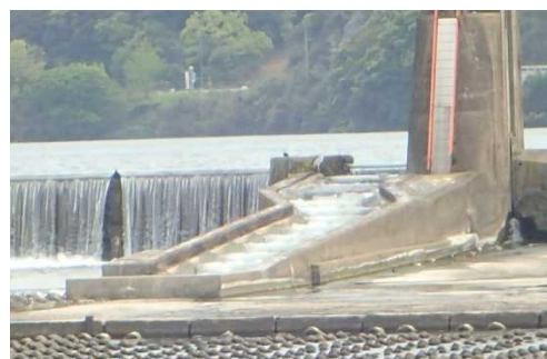
遙拝堰の魚道（改修後）
