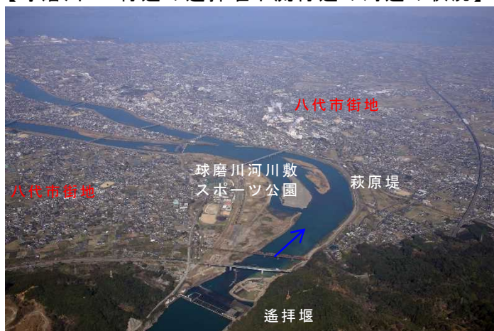
【球磨川 9k 付近の遙拝堰下流付近の河道の状況】
