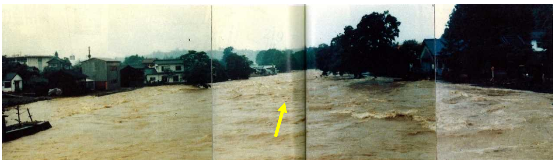
支川胸川沿いの浸水状況（田町橋下流、人吉市）
