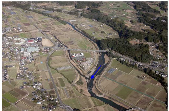
【球磨川上流部の河道の状況 89k 付近】
