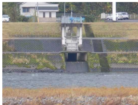
樋門の段差状況
