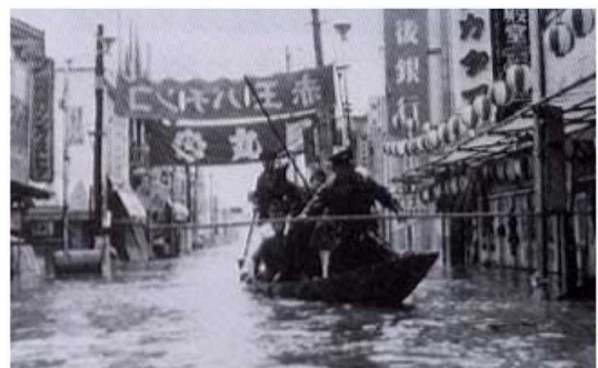
人吉市街地の浸水状況（人吉市九日町）
