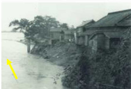
萩原堤防の一部決壊状況（八代市萩原町）
