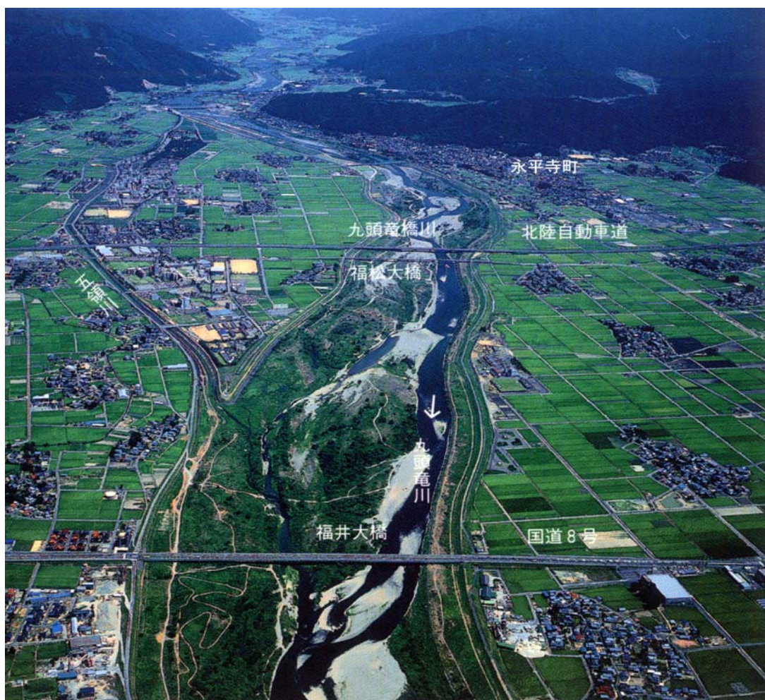
写真 2-2 九頭竜川中流 24km付近
