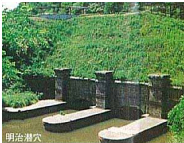
明治潜穴（北上川下流河川事務所 HP）
