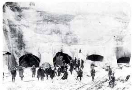
明治潜穴開削の様子
