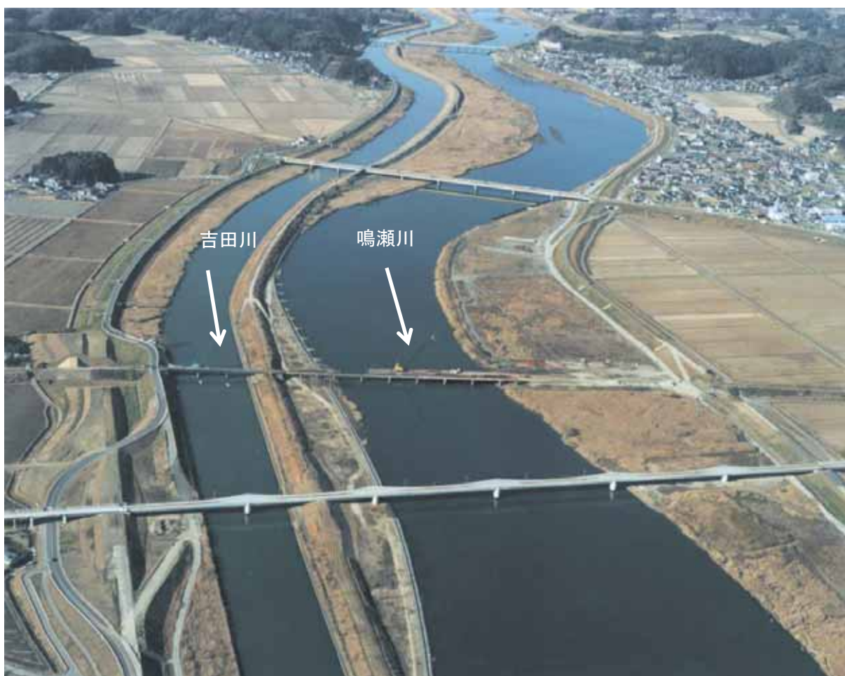
JR 仙石線鳴瀬川鉄道橋付近を鳴瀬川と併流する支川吉田川（北上川下流河川事務所資料）
