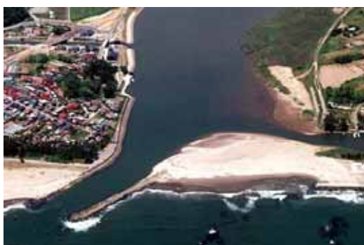
鳴瀬川河口付近の状況/北上川下流河川事務所
