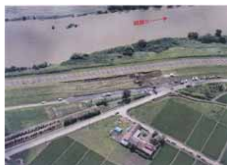
宮城県北部地震（平成 15 年 7 月 26 日発生）の被害状況
