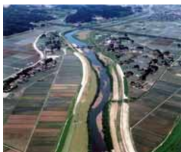
桑折江堰(H15 完成)
