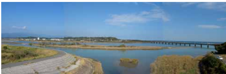
写真 8-5 宮田川より小丸川河口を望む
