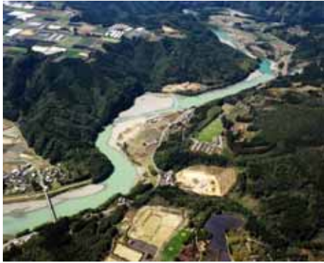
【小丸川中流部】 (比木橋付近・黒水川合流点上流付近) 山間地より解放され河岸段丘の趣を成す。 扇状地形の中を緩やかに蛇行する河川形状 を呈している。
