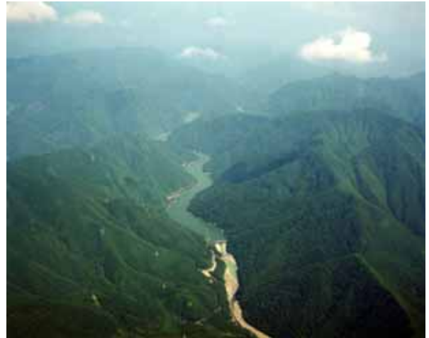
【小丸川上流部（松尾ダム付近）】
