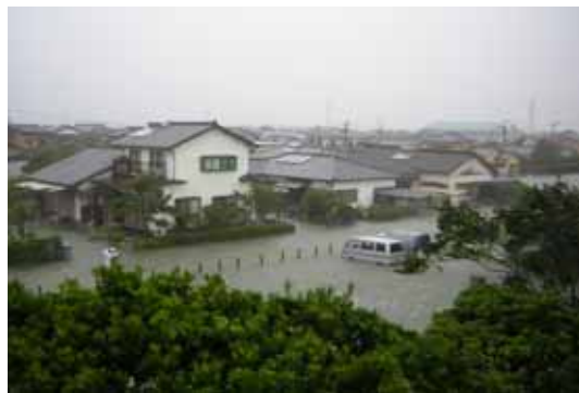
内水被害状況 (高鍋町)
