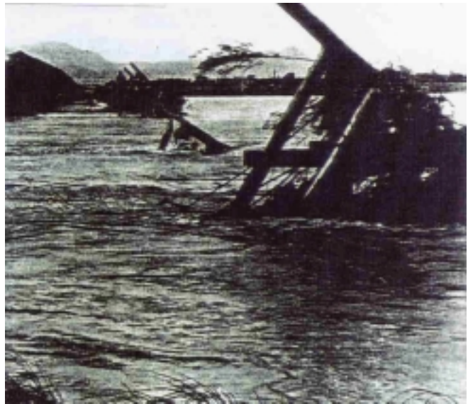
流出した高松橋(宮崎市)
