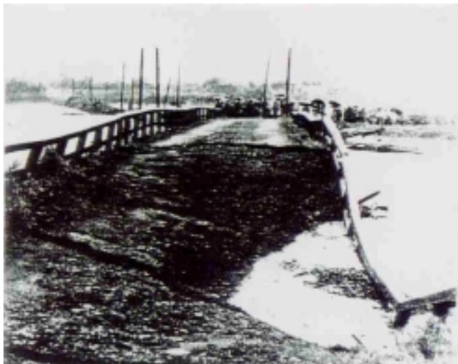
流出寸前の赤星橋 （都城市）
