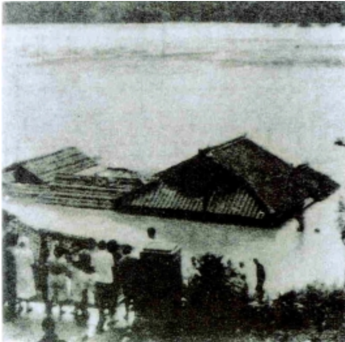
軒先まで浸水した家 (高岡町)
