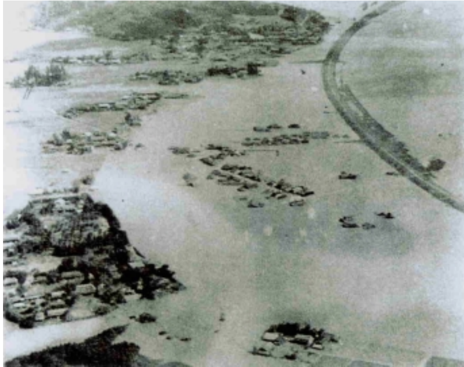
右岸大塚町付近の浸水状況（宮崎市）
