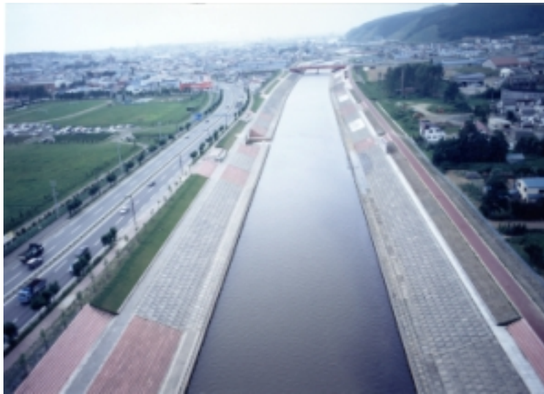
▲写真 - 4 河道状況（下流部）
