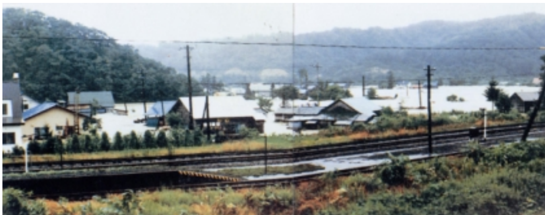
▲写真 - 17 昭和56年8月（大和田市街地の浸水状況）
