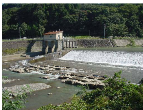
板倉発電所取水堰堤
