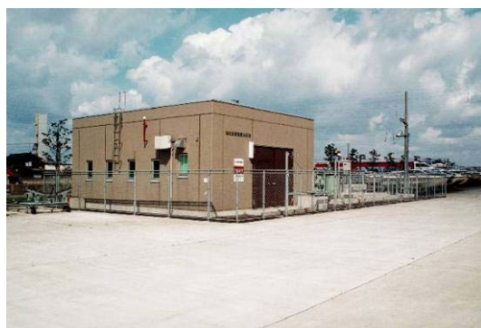
かすがしんでんかわ 春日新田川排水機場
