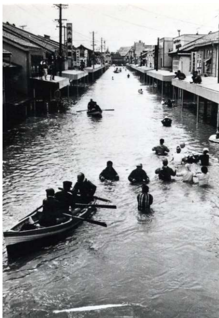
直江津駅前浸水状況
