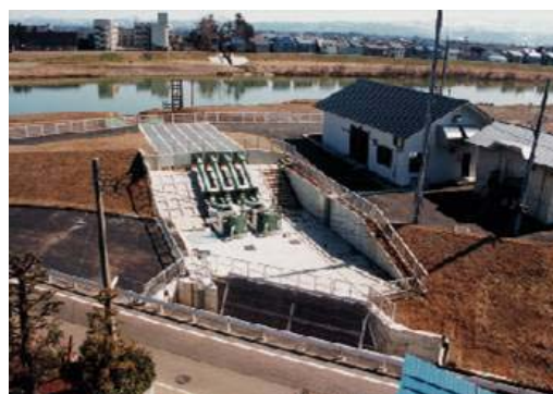
すいとかわ 水戸の川排水機場
