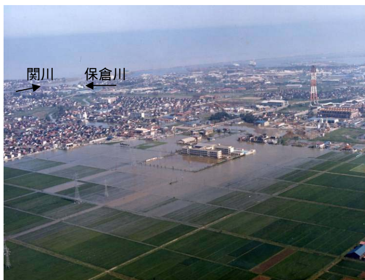
上越市福田地先湛水状況
