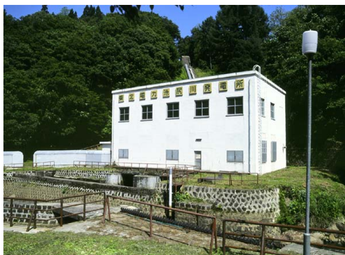
池尻川発電所（日本最初の揚水式発電所）
