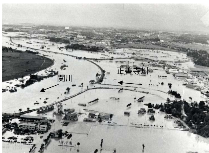
春日山橋から上流の氾濫状況（上越市木田）
