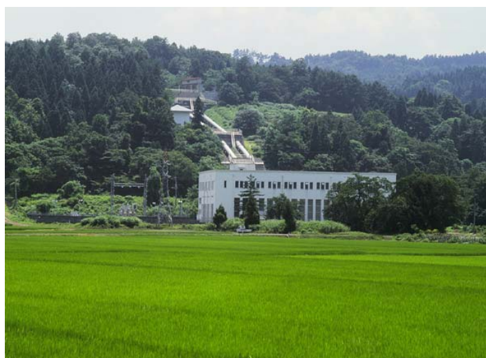
板倉発電所（発電とかんがいの中継点）
