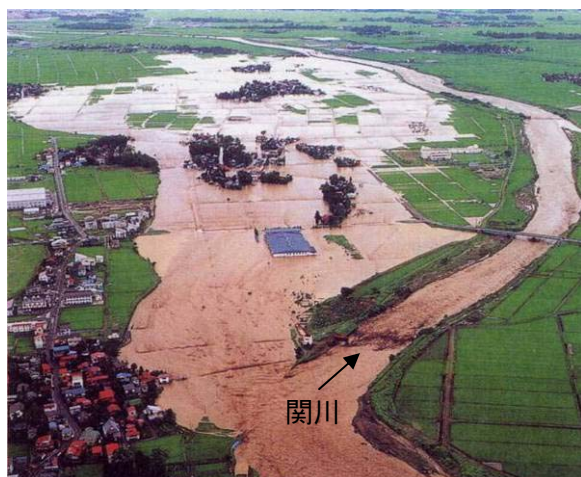
新井市月岡地先破堤状況
