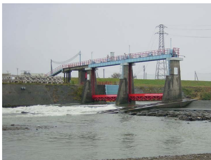
上越工業用水道関川取水堰
