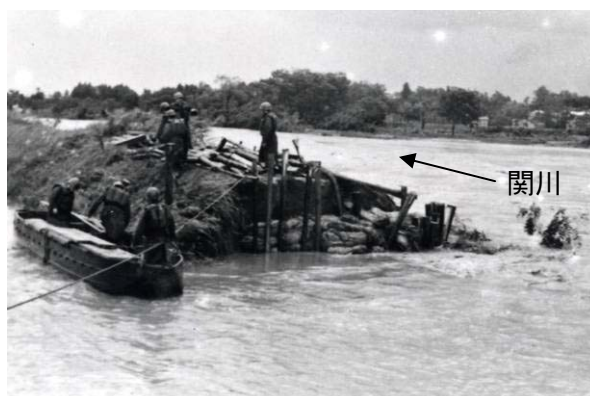
中央橋左岸破堤状況
