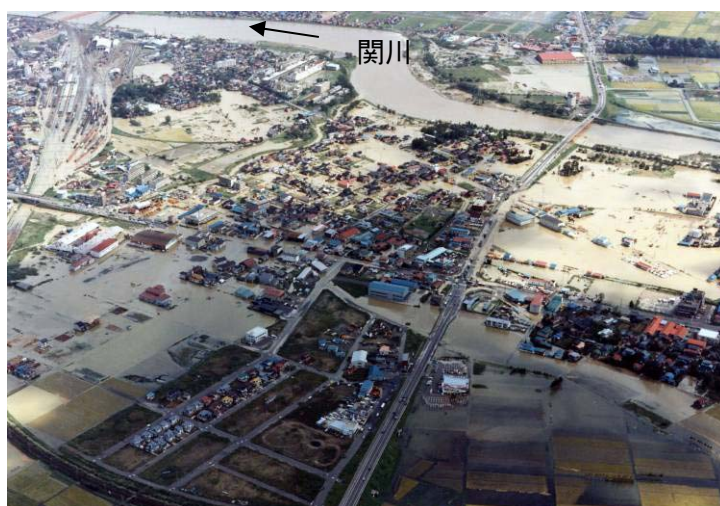
上空より関川大橋を望む
