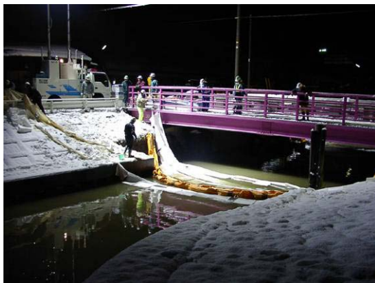
オイルフェンス設置状況
