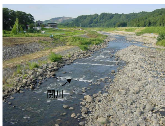
猿橋より下流を望む ( 妙高市 )
