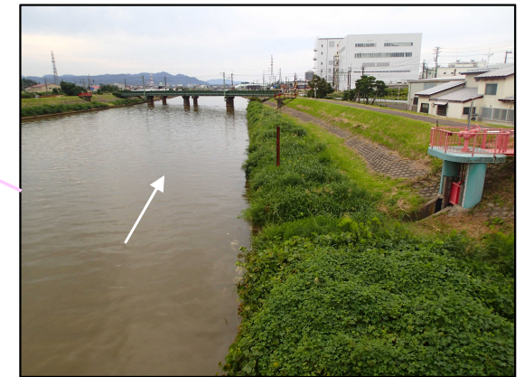
保倉川現況写真
