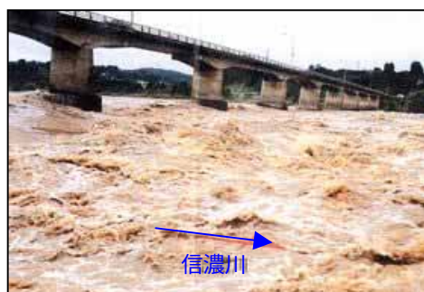
写真 4-40 十日町橋の状況
