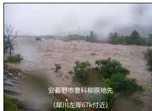
平成18年7月洪水河岸欠損状況
