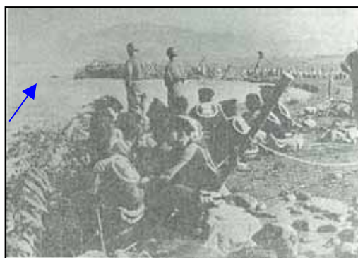
写真 4-14 犀川右岸明科地区付近の水防作業
