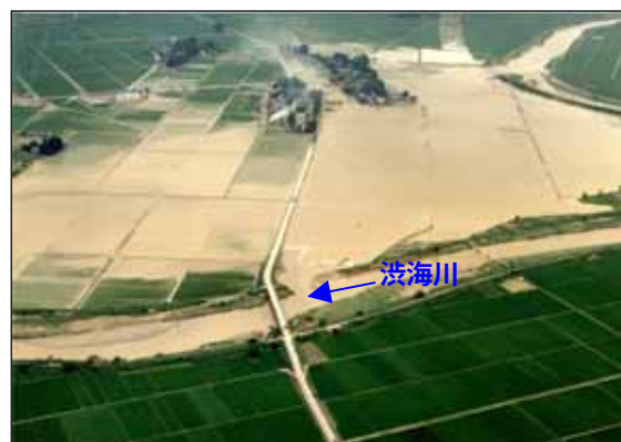
写真 4-24 渋海川破堤状況
