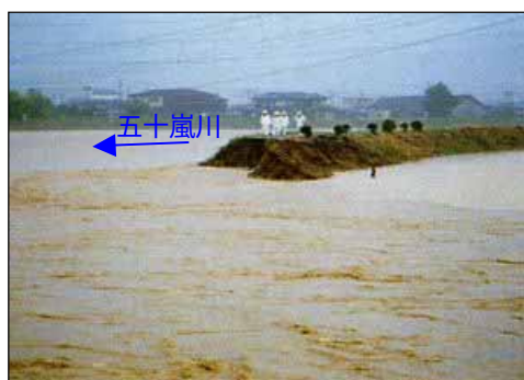
写真 4-42 五十嵐川の破堤状況
