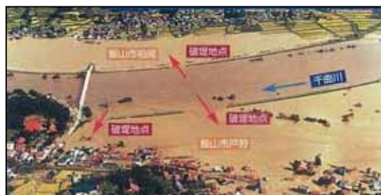
写真 4-35 千曲川の破堤状況
