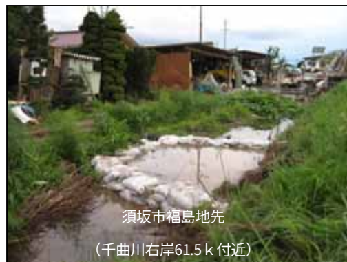
平成18年7月洪水堤防漏水状況
