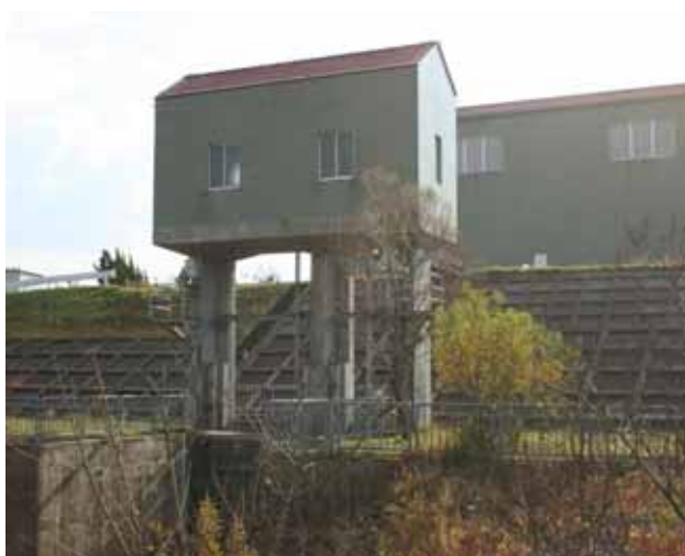
写真 4-79 柿川排水機場
