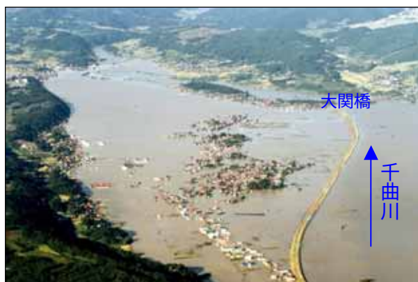
写真 4-37 昭和 58 年 9 月台風 10 号による出水状況
