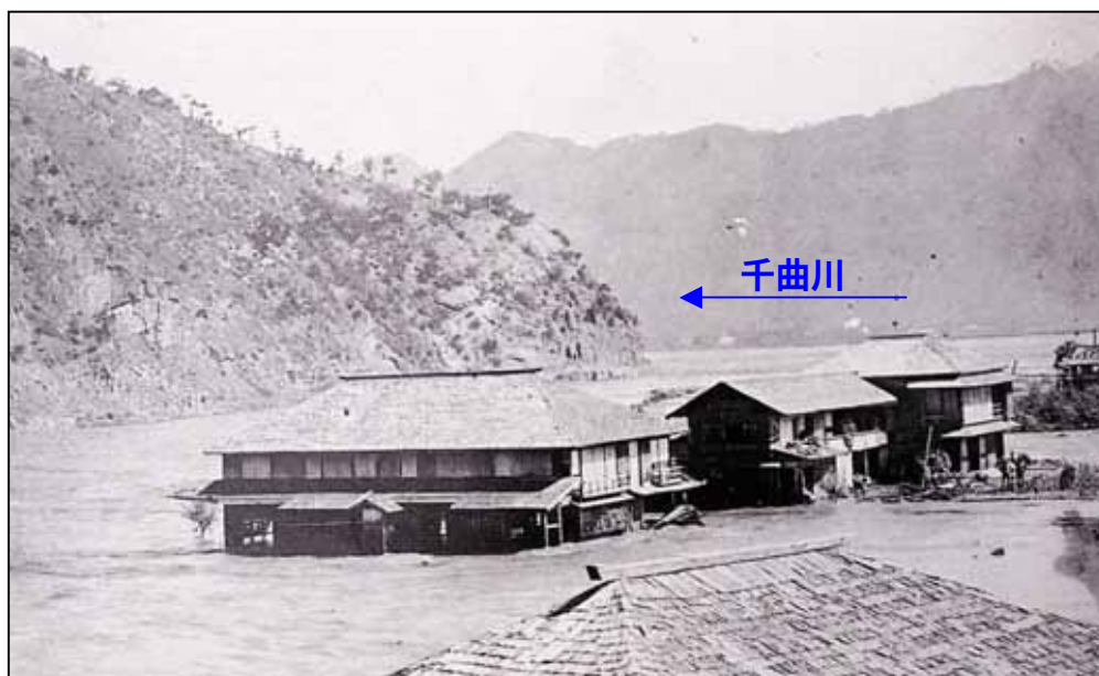
写真 4-2 明治 43 年戸倉上山田温泉の浸水
