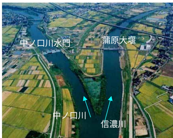
写真 4-88 蒲原大堰と中ノ口川水門
