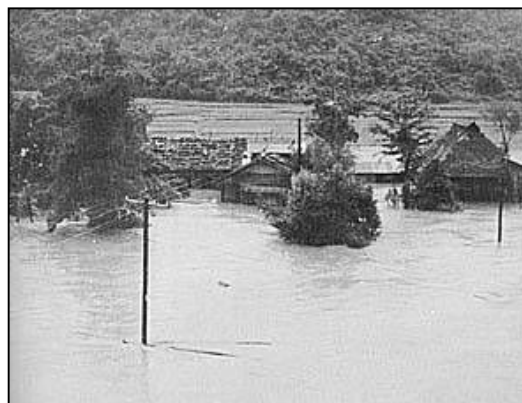
写真 4-19 旧下田村小外谷地区(鹿熊川)
