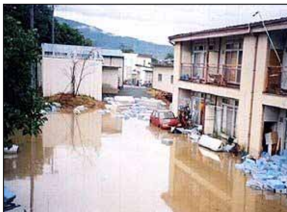
写真 4-41 旧更埴市浸水状況
