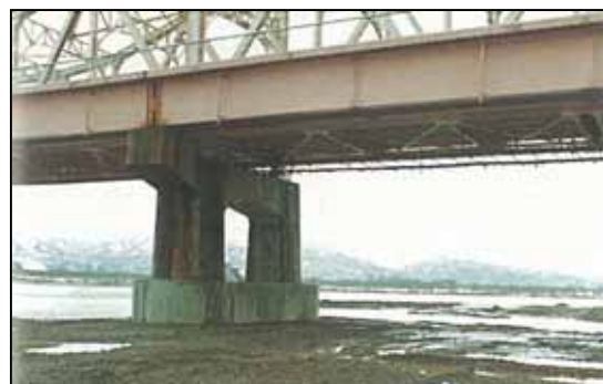
写真 4-74 長生橋橋脚補強工事
