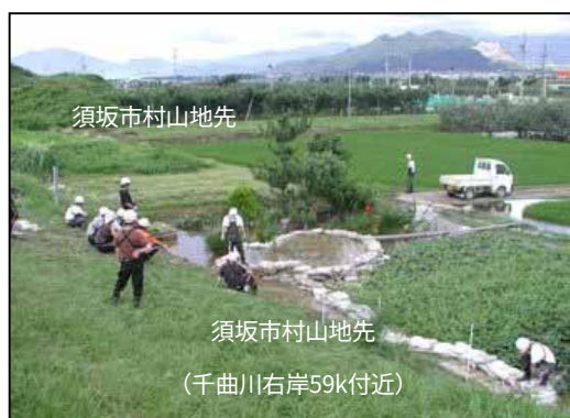
平成18年7月洪水堤防漏水状況
