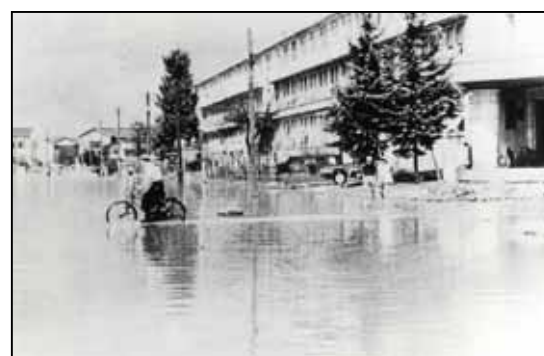
写真 4-10 柿川流域の浸水状況 (旧日赤病院前)
