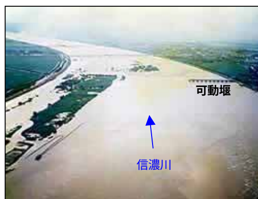
写真 4-38 大河津可動堰付近の様子
