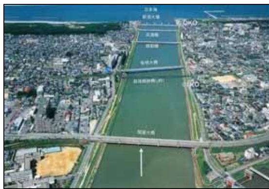
写真 4-85 関屋分水路(現在)
