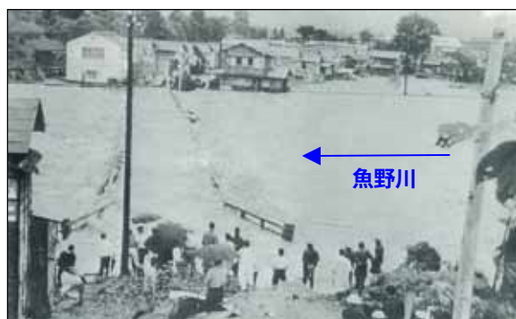
写真 4-9 魚野川 柳生橋付近の様子
