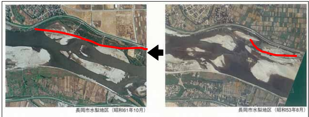
写真 4-71 長岡市水梨地区河道状況
