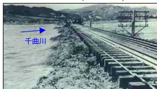
写真 4-11 信越線篠ノ井鉄橋での出水状況
