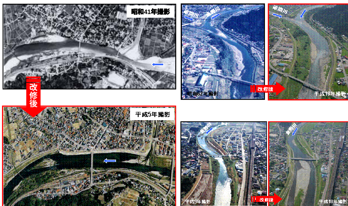
図 4-53 改修前後の様子
