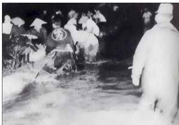
写真 4-17 水防作業の様子
