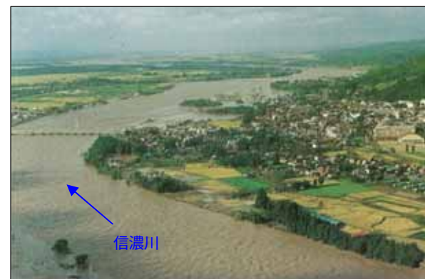
写真 4-34 東小千谷地区旭橋の状況
