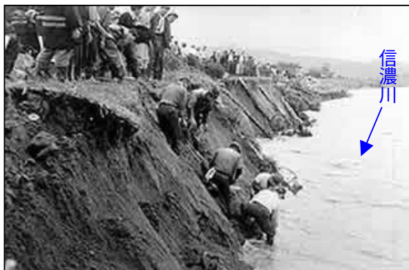
写真 4-15 長岡水梨地区の堤防欠壊状況
