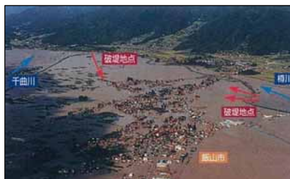
写真 4-32 樽川の破堤状況
