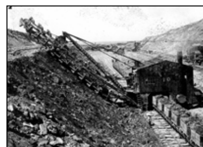
写真 4-61 大河津分水路開削工事 実施状況
