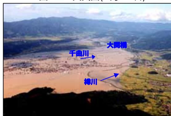
写真 4-30 昭和 57 年 9 月 18 号による出水状況
