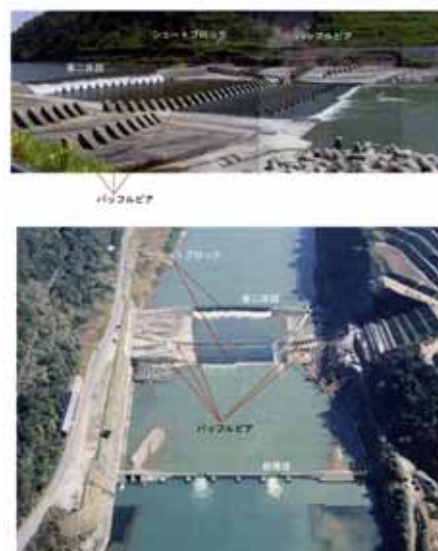
写真 4-65 バッフルピアの設置状況
