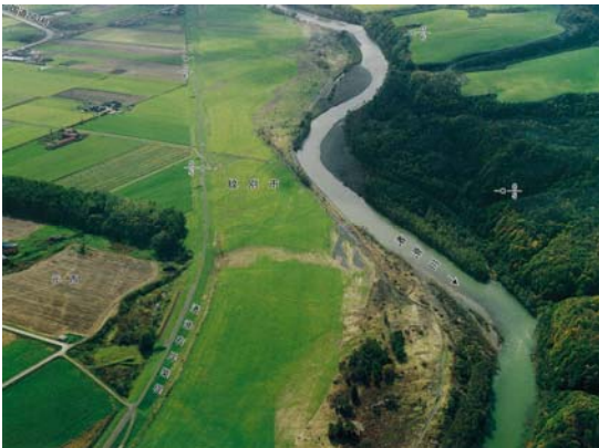
写真 2-18 KP 5.0 付近より上流
