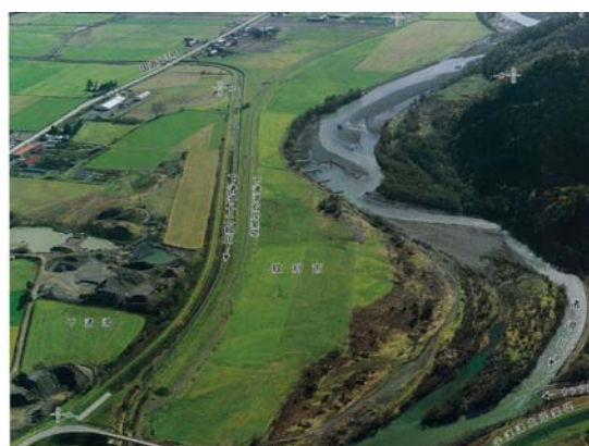
写真 2-17 KP 8.0 付近より上流 (左岸はケショウヤナギ群落)
