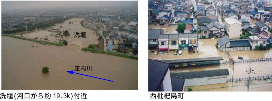
図 4 - 2 近年の洪水被害(平成 12 年 9 月洪水)
