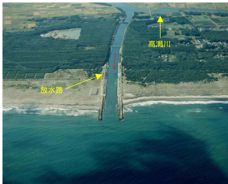
図 4.2.1 放水路の整備状況（現況）
