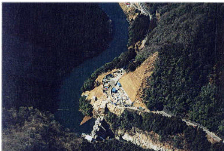
上流部白丸 ダム付近 （山間溪谷部）
