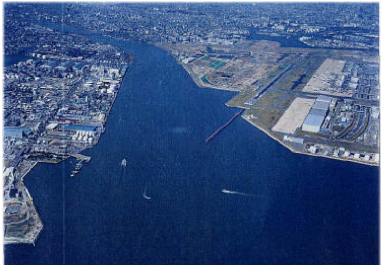
下流部 -2k 付近 (埋立部)
