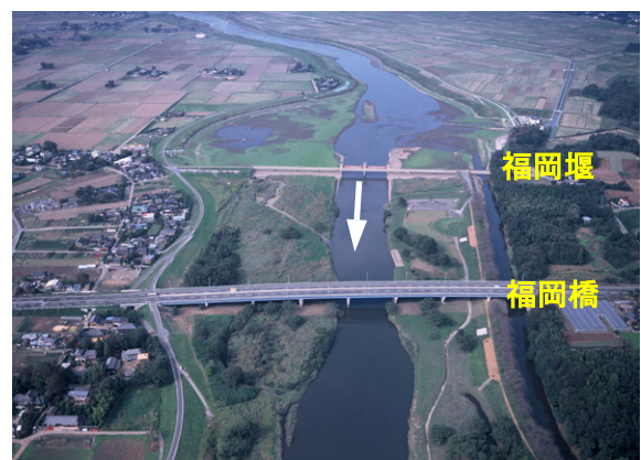
写真 8-24 福岡堰周辺（約 27km）
