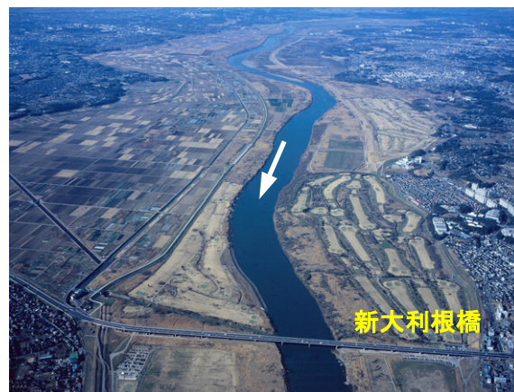
写真 8-6 田中稲戸井調節池周辺 (約 90km)
