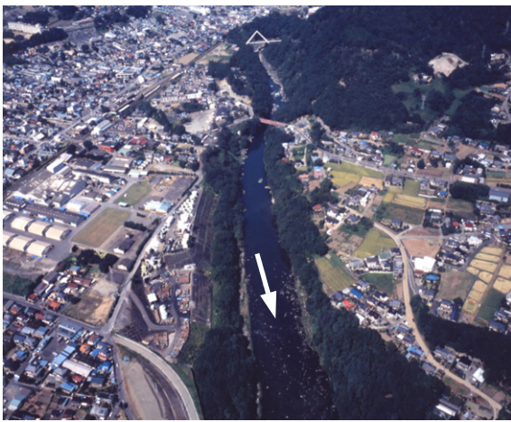
写真 8-15 高津戸地点(約 56km)
