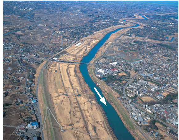
写真 8-32 野田橋 (約 39km) 下流
