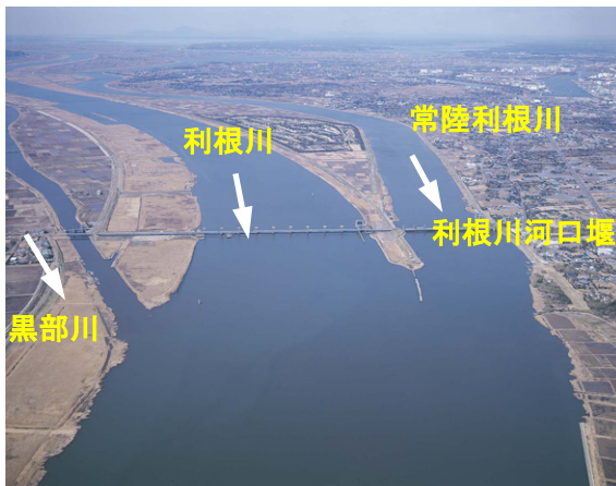
写真 8-9 利根川河口堰 (約 19km)
