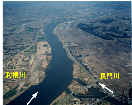
写真 8-8 長門川合流 (約 66km)
