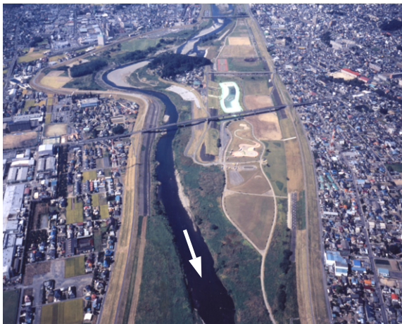
写真 8-17 岩井分水路地点(約 33km)
