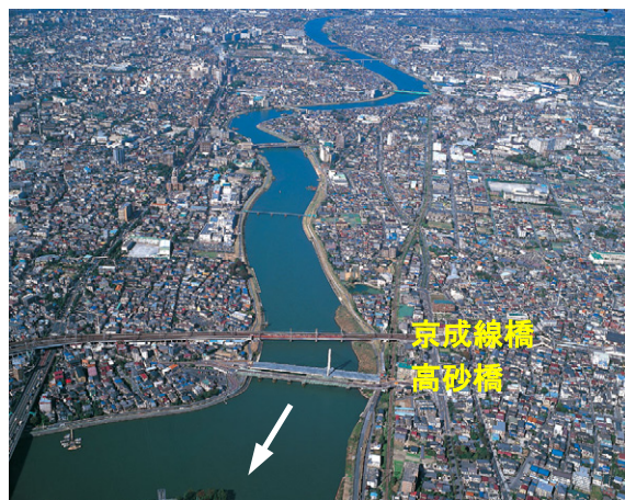
写真 8-36 中川京成線橋（約 12km）付近
