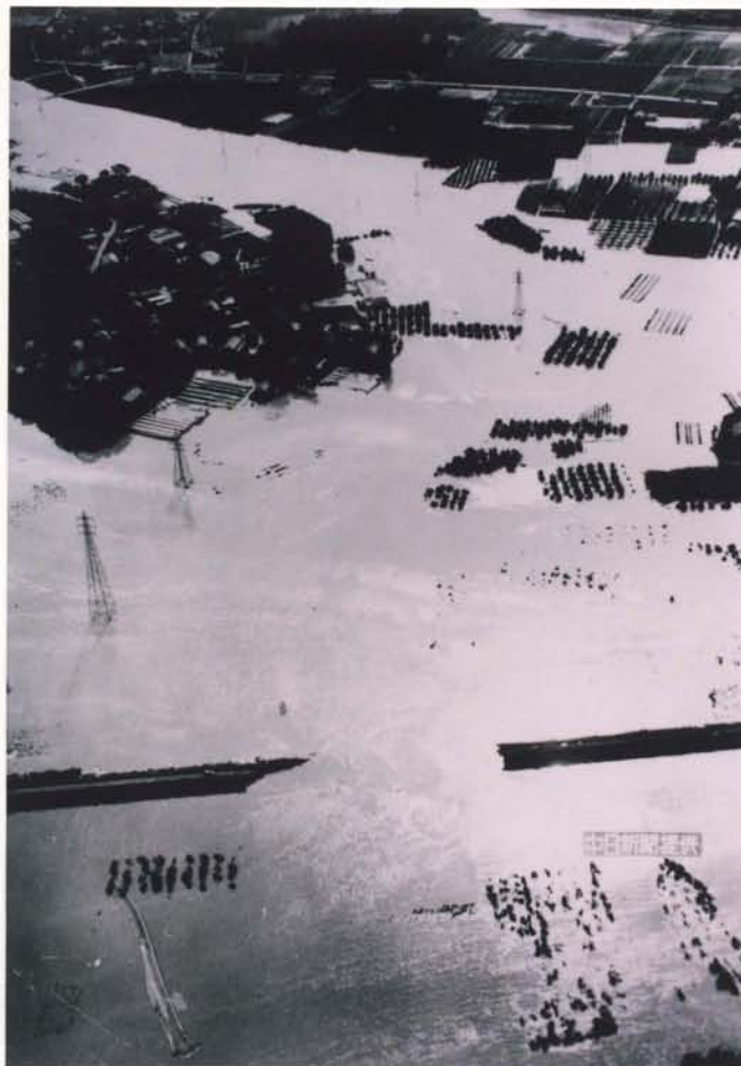
昭和44年8月洪水による堤防決壊 一宮町江島
