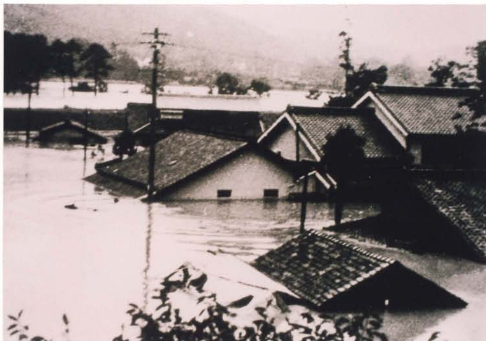
昭和43年8月洪水における浸水状況 新城市豊島
