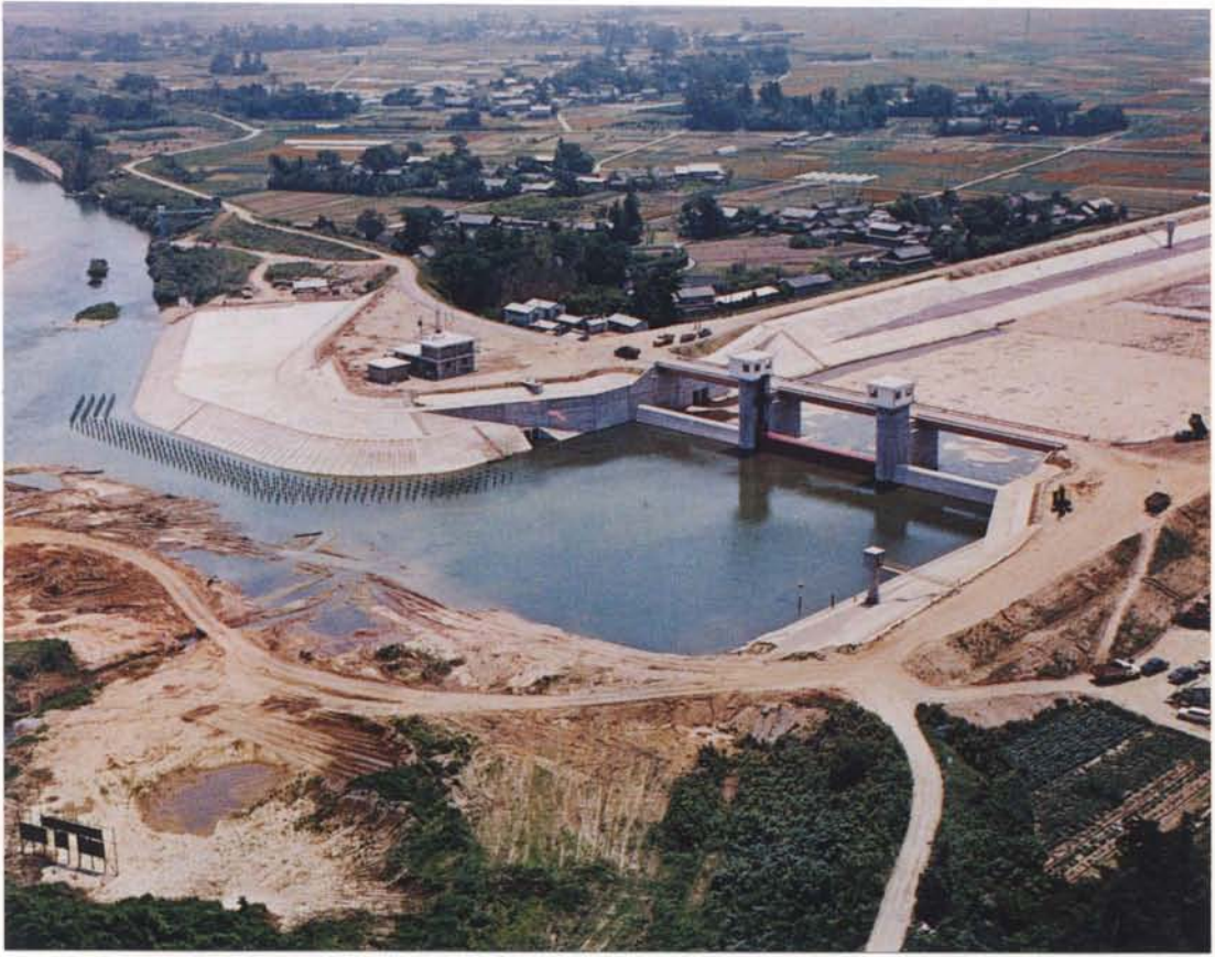
豊川放水路分流堰施工（昭和40年）
