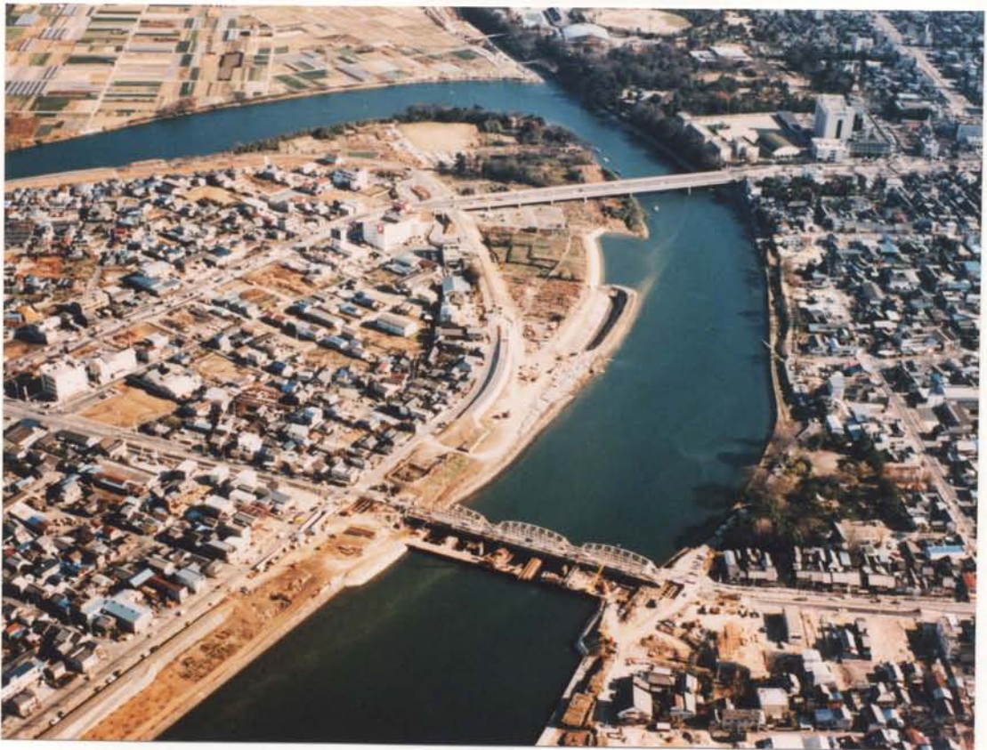
豊橋市内狭窄部対策工事（昭和58年）
