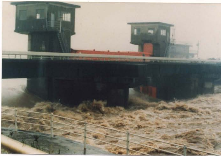
分流中の豊川放水路（S57.8洪水）
