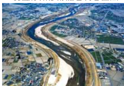
JR 東海道新幹線下流 (河口から 15km 付近)
