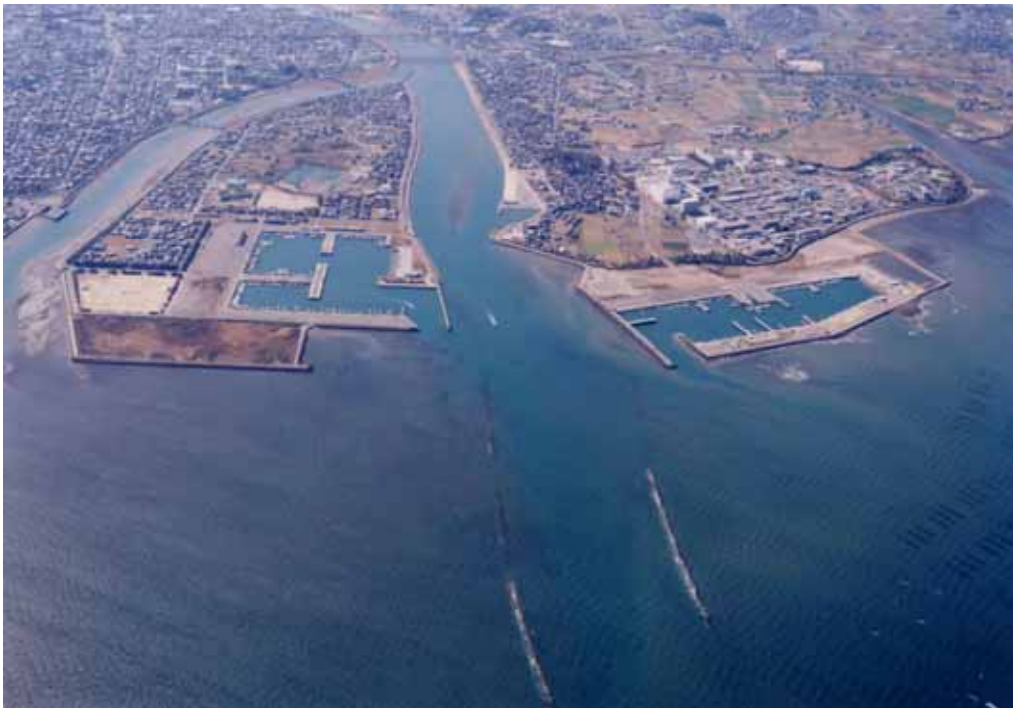
【山国川河口部と派川中津川の全景】
