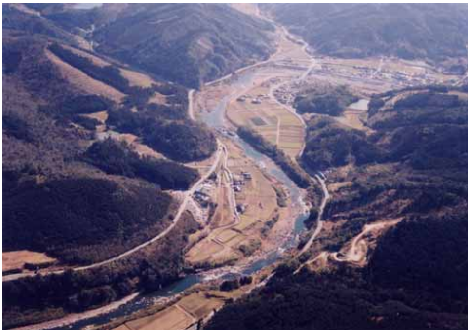
【中流部の全景 河口から 14km】
