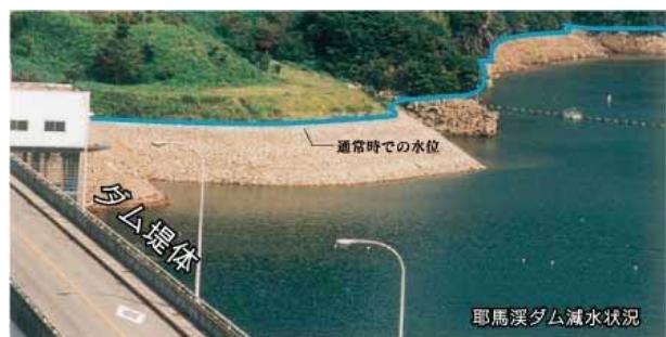
写真 5-4 耶馬溪ダムの湯水状況 (平成 13 年)
