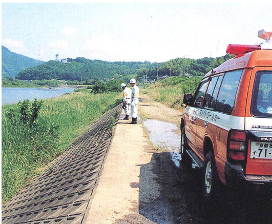
写真 8.1 河川巡視状況
