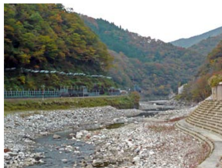
②水流のない箇所（打保ダム下流）
