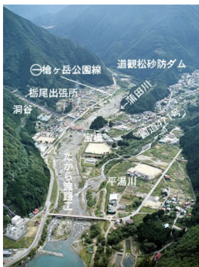
写真④ たから流路工
