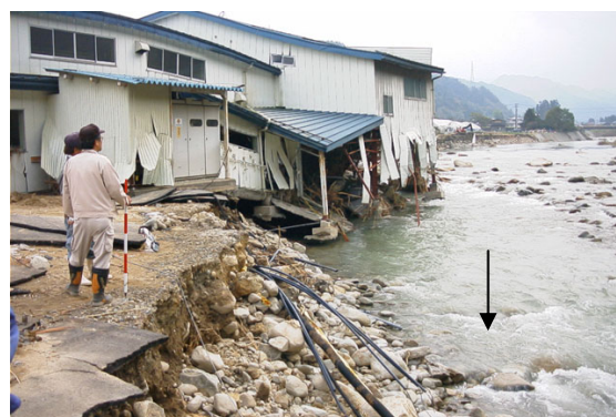
上流部被災状況 (高山市清見町)
