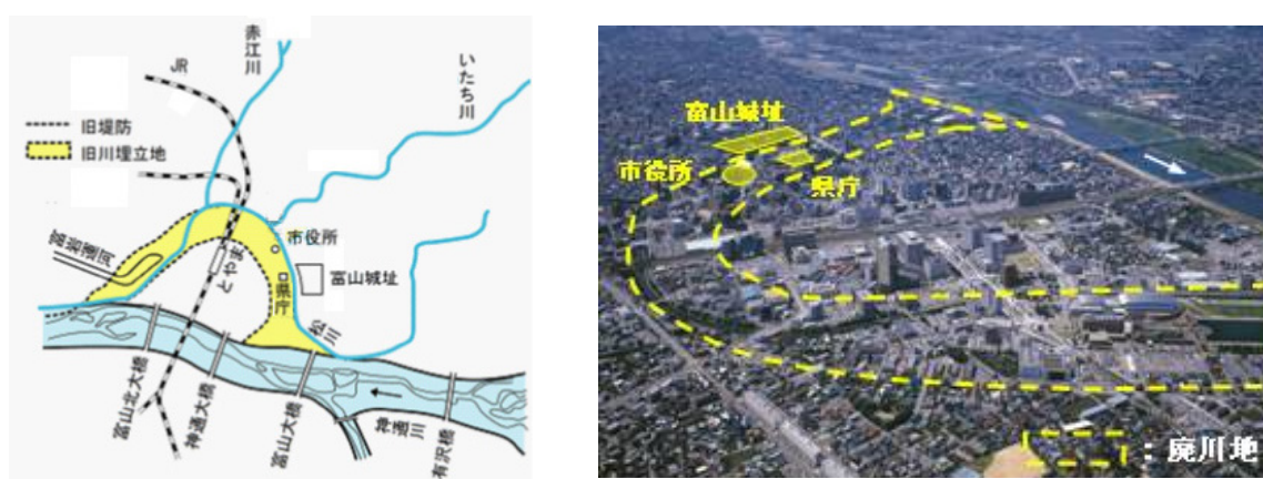
図 4-2 馳越線新設工事
