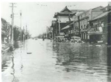
洪水により水没した岡山市内(昭和9年)
