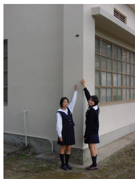
岡山市内の工場に残る最高水位標識
