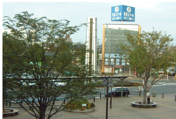
久喜駅前の「水位表示塔」の設置状況
