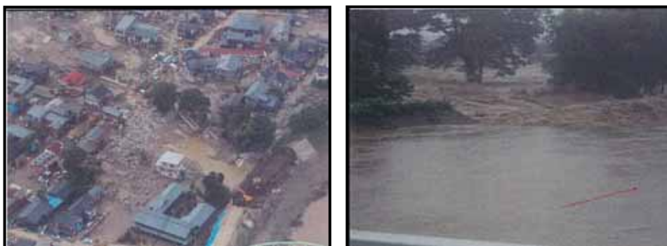
図4 決壊口付近の被害状況（平成16年7月 新潟県中之島町 刈谷田川） （出典：「水害レポート2004」 平成17年3月 （社）日本河川協会）
