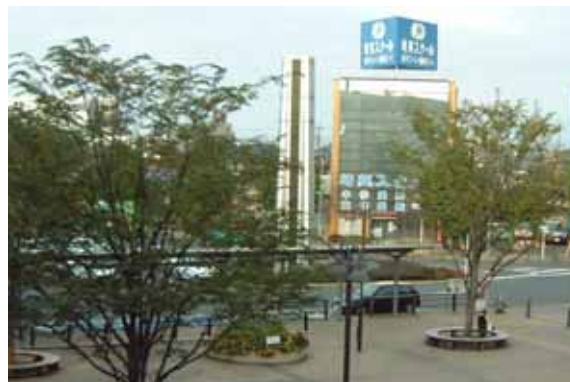
久喜駅前の「水位表示塔」の設置状況
