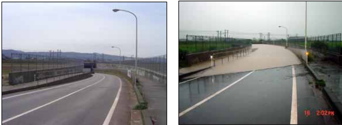
図6 平成16年7月 新潟県三条市アンダーパスの浸水状況(左 平常時、右 浸水時)
