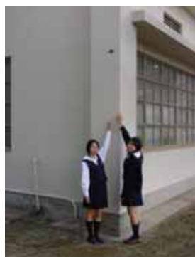
岡山市内の工場に残る最高水位標識
