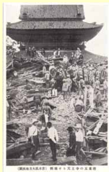
（関西地方大気学） 倒壊せる四天王寺の五重塔
