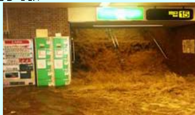
地下街のはん濫状況 福岡市
