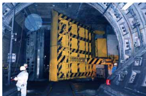
トンネル内浸水対策 105) (防水ゲート)
