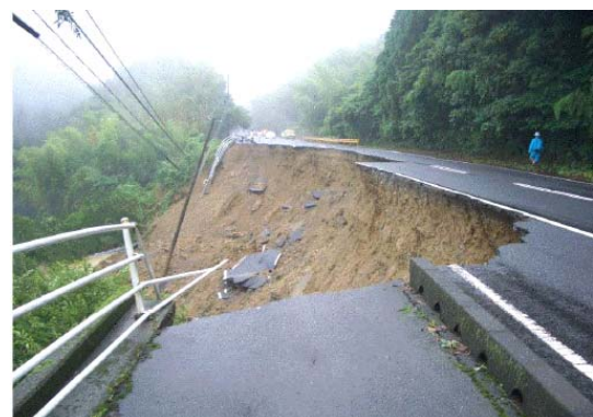
平成22年豪雨による法面崩壊状況
