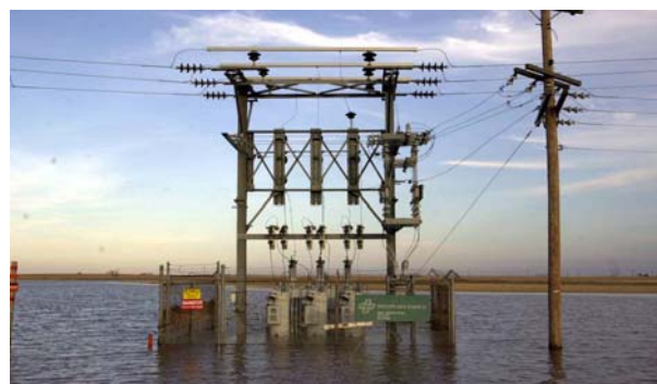
浸水による電力施設の損傷
