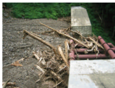
【鋼製砂防えん堤が土石流及び流木を捕捉し被害を未然に防止 (福井県今立町)】
