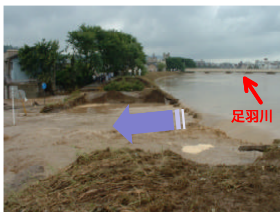
【九頭竜川水系足羽川の破堤状況 ( 福 井 県 福 井 市 )】
