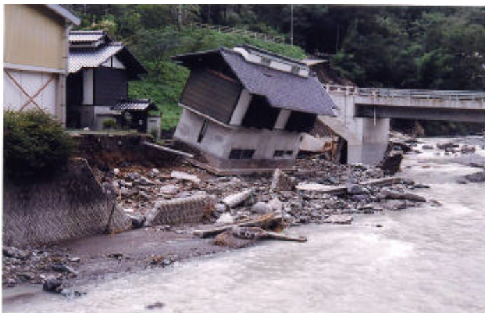
【河岸決壊により流されそうになって いる家屋(宮崎県椎葉村)】
