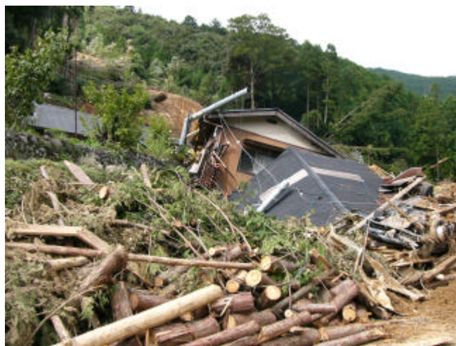
【土石流により損壊した家屋 (三重県宮川村)】
