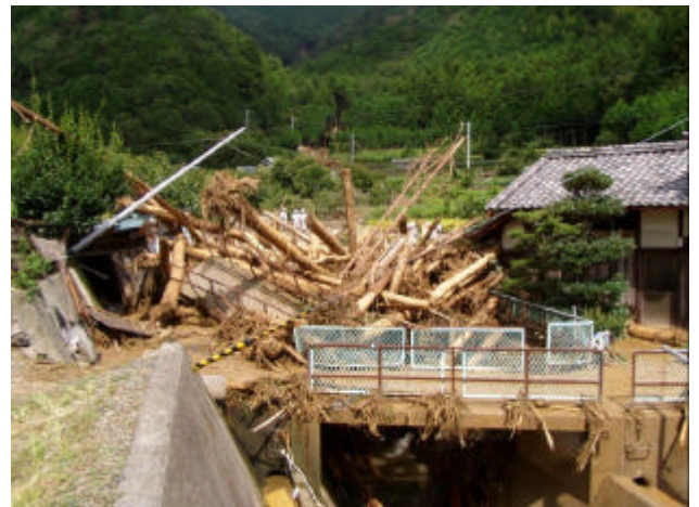
【土石流により損壊した家屋 (愛媛県西予市)】
