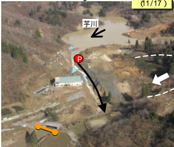
【地震後の降雨等により湛水位は最高でEL=157.7mを記録】
