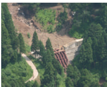
【鋼製砂防えん堤が土石流及び流木を捕捉し被害を未然に防止 (福井県今立町)】
