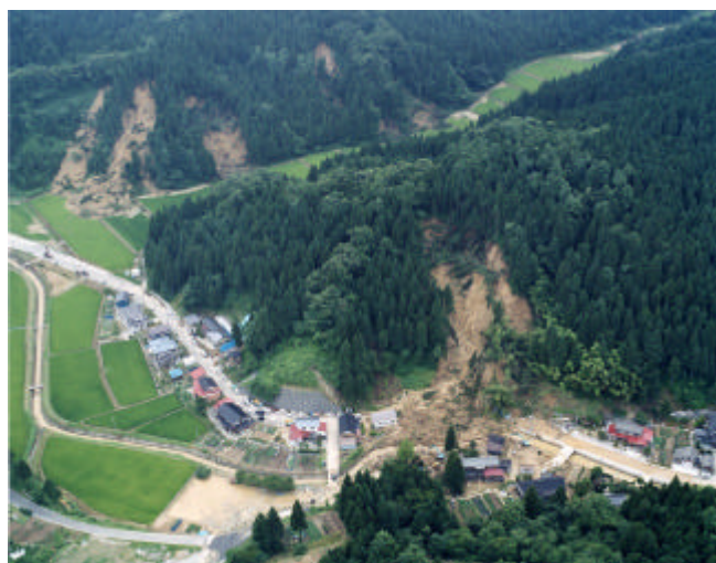
【複数箇所同時発生した地すべり （新潟県三島町）】
