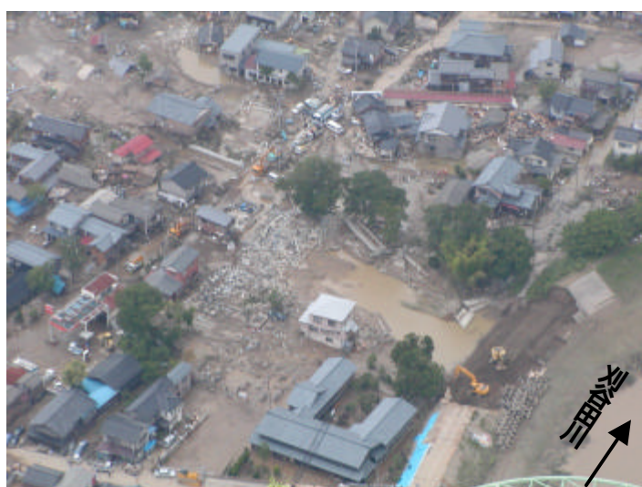
【破堤により流失した家屋 （新潟県中之島町）】
