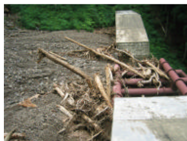
【鋼製砂防えん堤が土石流及び流木を捕捉し被害を未然に防止(福井県今立町)】
