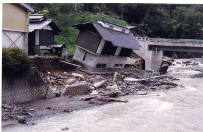
【河岸決壊により流されそうになって いる家屋(宮崎県椎葉村)】
