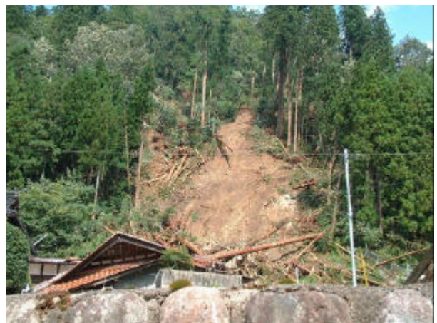
【がけ崩れにより損壊した家屋 （広島県筒賀村）】
