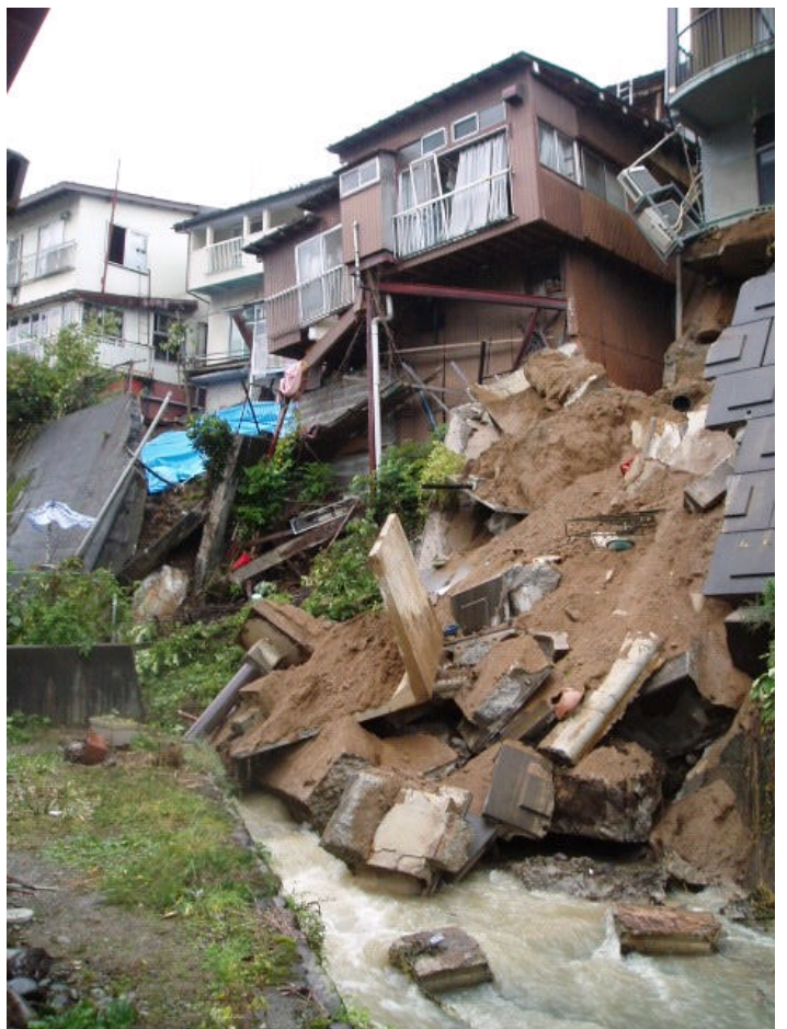
【護岸の崩壊により流されそうになっている家屋 (新潟県小千谷市(湯殿川))】
